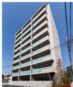
愛知県刈谷市若松町 全24戸 2019年3月 竣工
