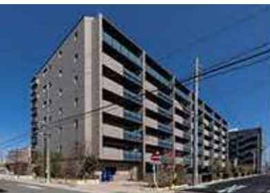
岐阜県岐阜市加納大黒町 全48戸 2019年2月 竣工
