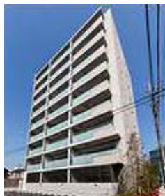
愛知県刈谷市若松町 全24戸 2019年3月 竣工
